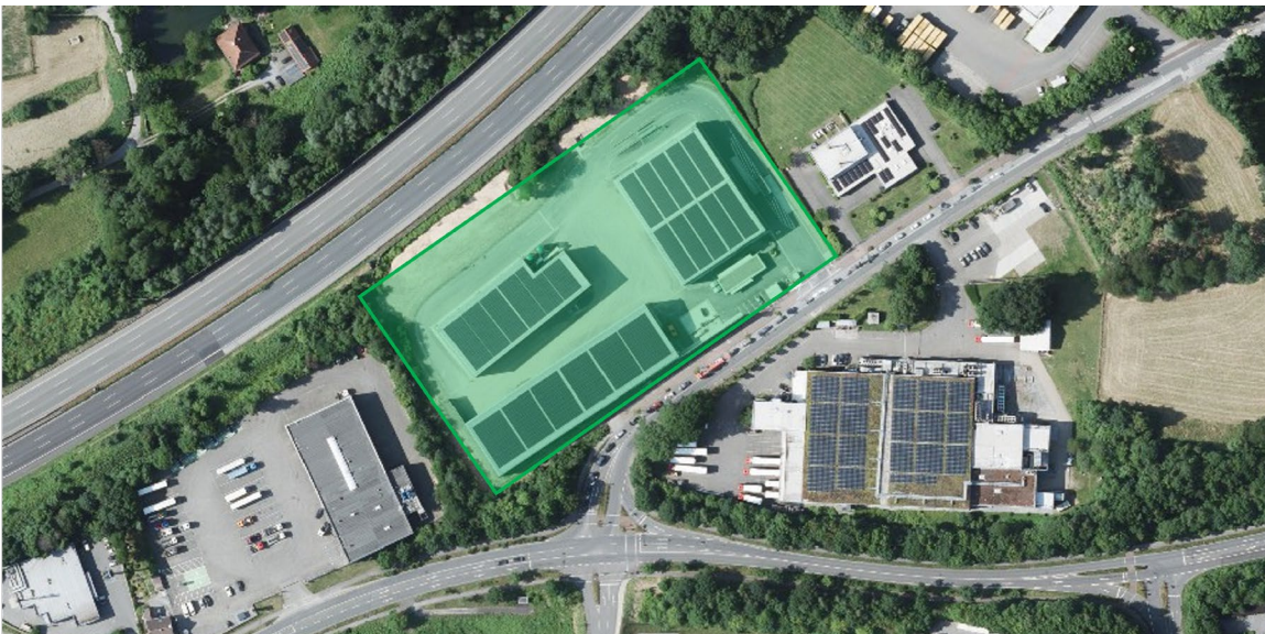
Abb. 11 Luftbild Betriebsgelände BRA am Standort Vohwinkel
